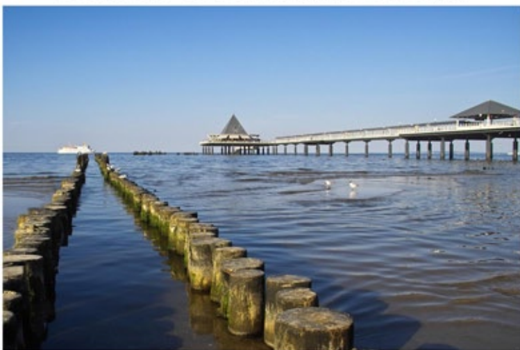
seebruecke heringsdorf buhnen 20 x 30.jpg
